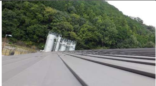
蓄電池設置想定箇所
