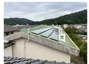
図 4-3 傾斜屋根設置例
