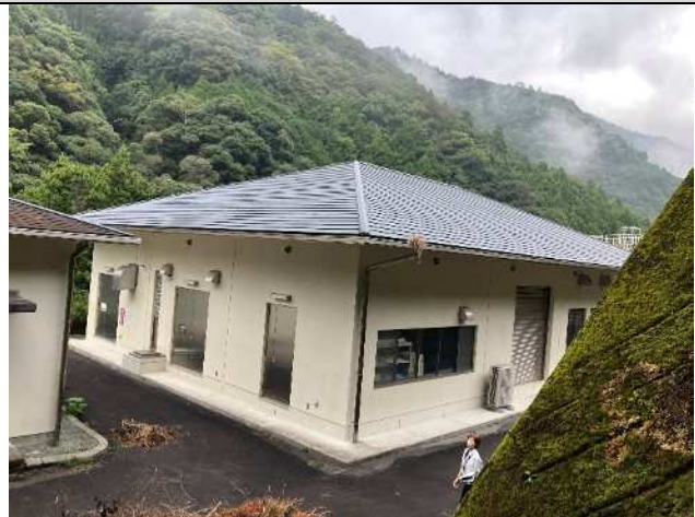
蓄電池設置想定箇所
