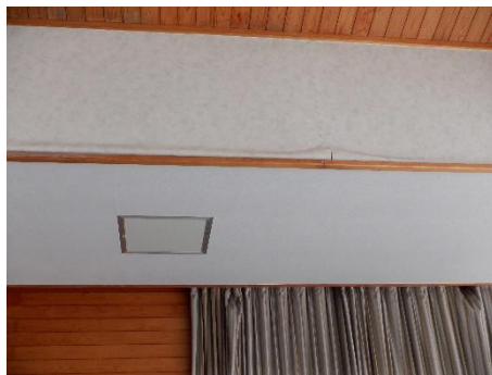
【劣化状況】 雨漏り被害
