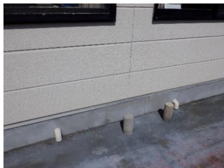
【劣化状況】ひび割れ被害
