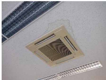
【劣化状況】ひび割れ被害
