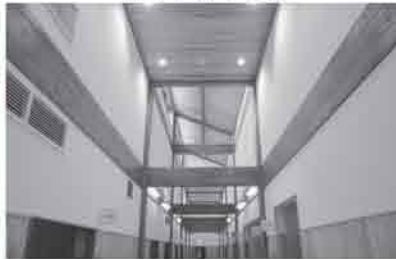
天井まで随所に構造材が見えており、木造の雰囲気が出た内観になっています。
