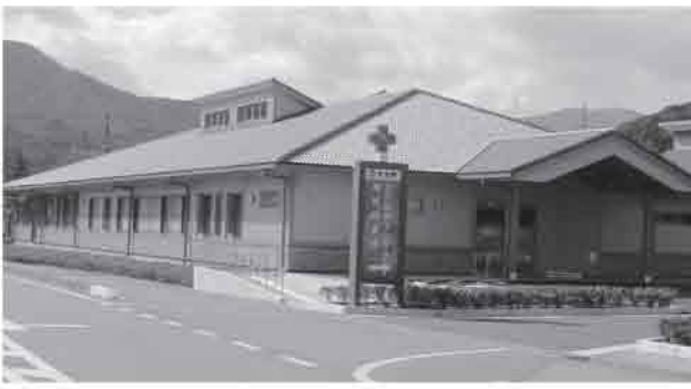
診療所は、柱等の構造材や壁、天井等の仕上げ材に町産の木材を使用しています。
