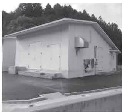
完成間近の丹生送水ポンプ所
