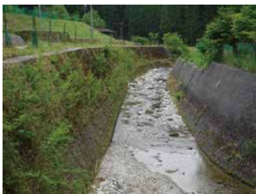
護岸浸食を防ぐための環境保全ブロックによる 施工箇所（栗谷地内）
