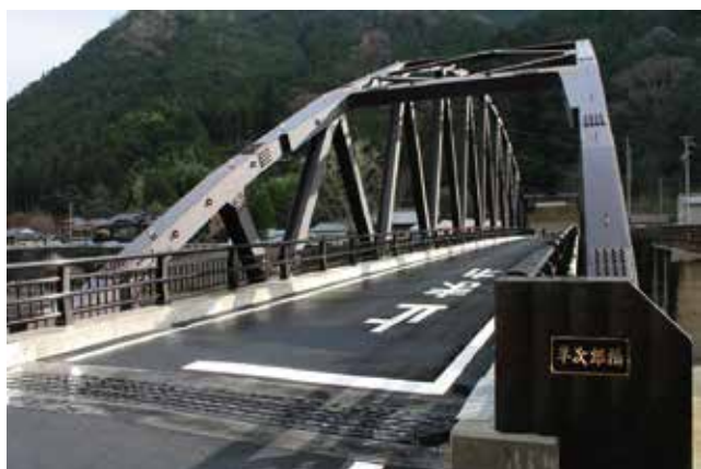
老朽化した橋梁を架け替えるなど住民の重要な生活経路を確保
