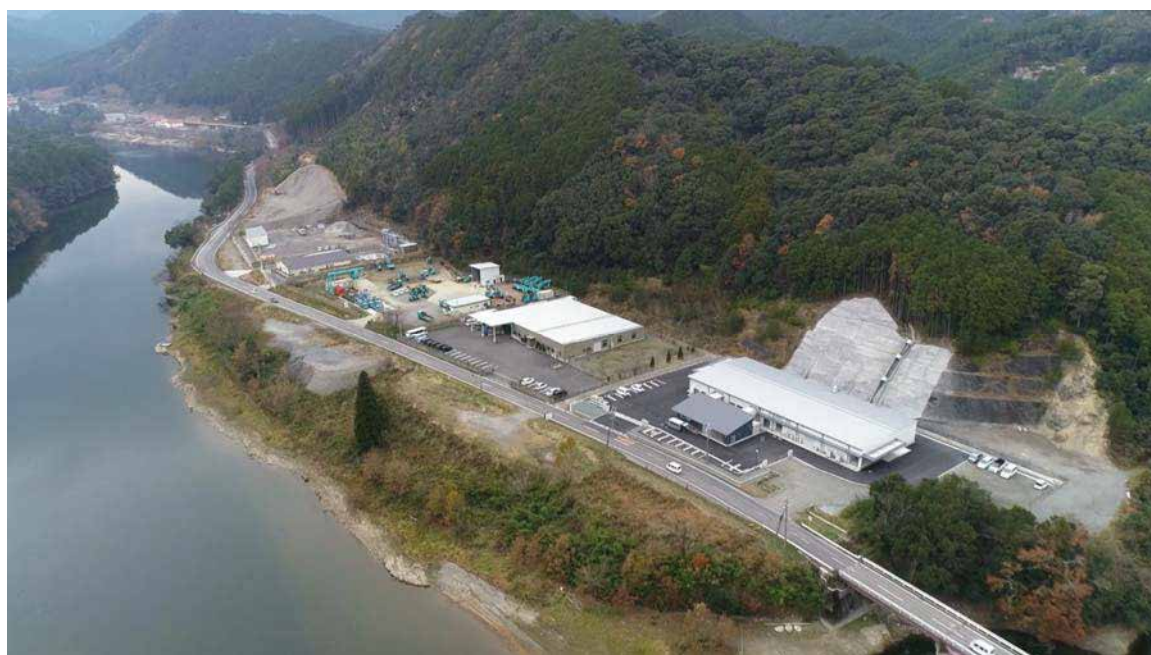
弥起井地内（藺井）の工場適地に整備された事業所
