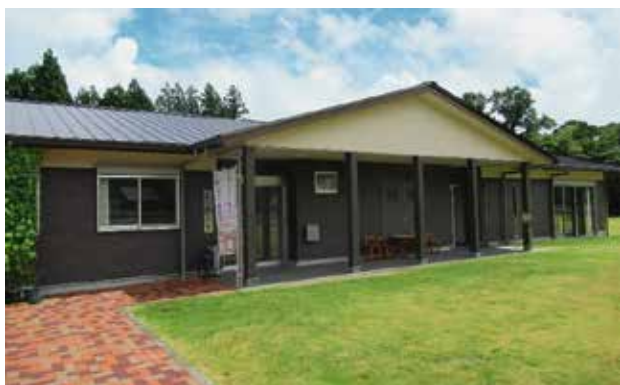
大台町 B&G 海洋センター 管理棟
