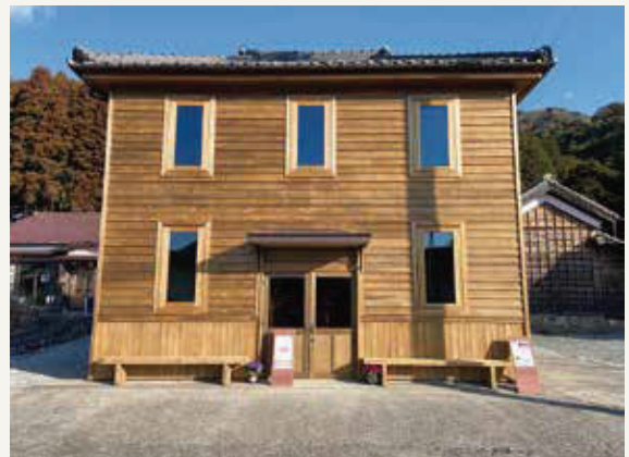
空き家の利活用(改修後)
