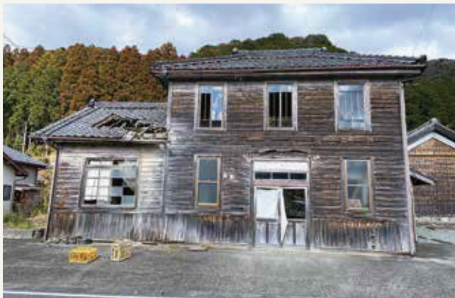
空き家の利活用(改修前)
