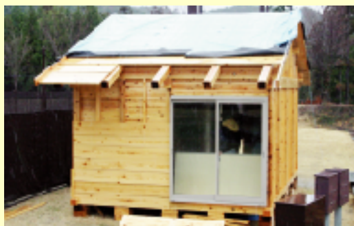
◀木造仮設住宅
